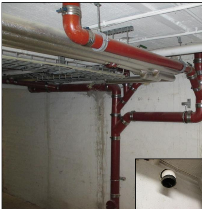
Nya spillvattenstammar i källare, äldre ej pluggad
