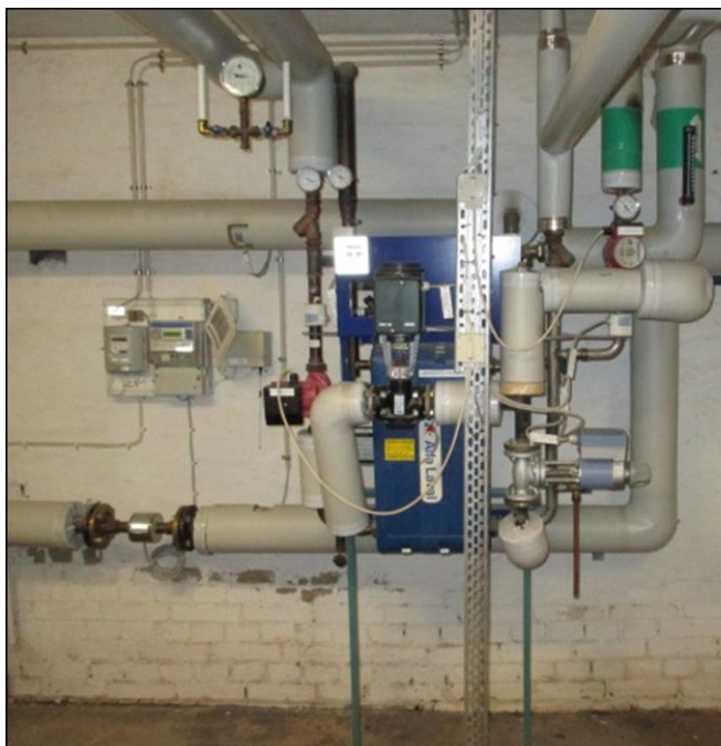
Fjärrvärmesväxlare i UC mot Carl Hillsgatan.
