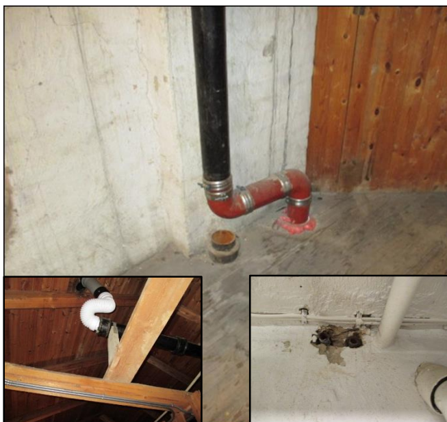
Äldre och ny luftare, samt tappvattenrör.
