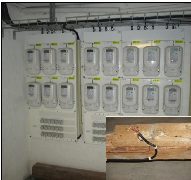
El för Carl Hillsgatan, samt lös kabel på vind.
