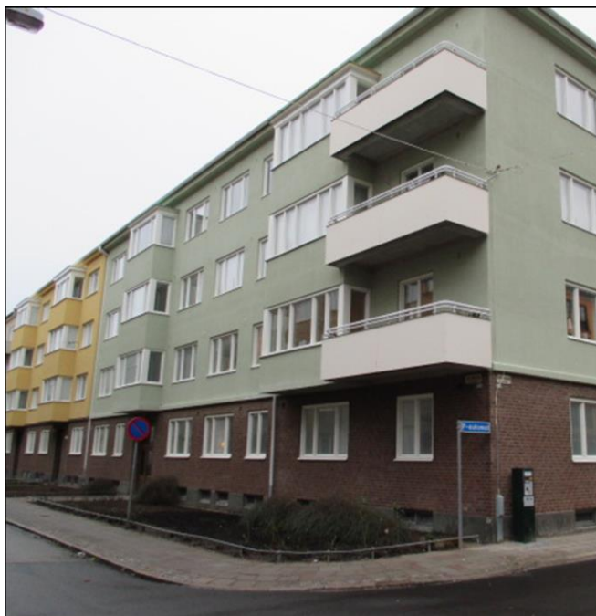
Fasad mot gata. Ny puts och nya fogar.
