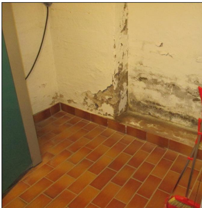
Fukt på källarvägg i tvättstuga.
