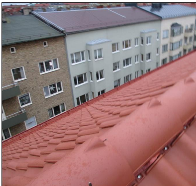
Tak mot Carl Hillsgata, med snörasskydd.
