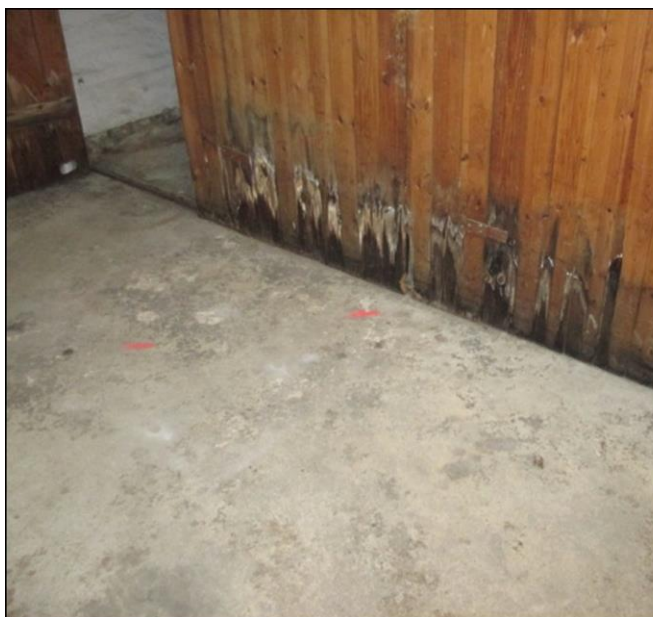
Förråddsväggar som är fuktangripna.
